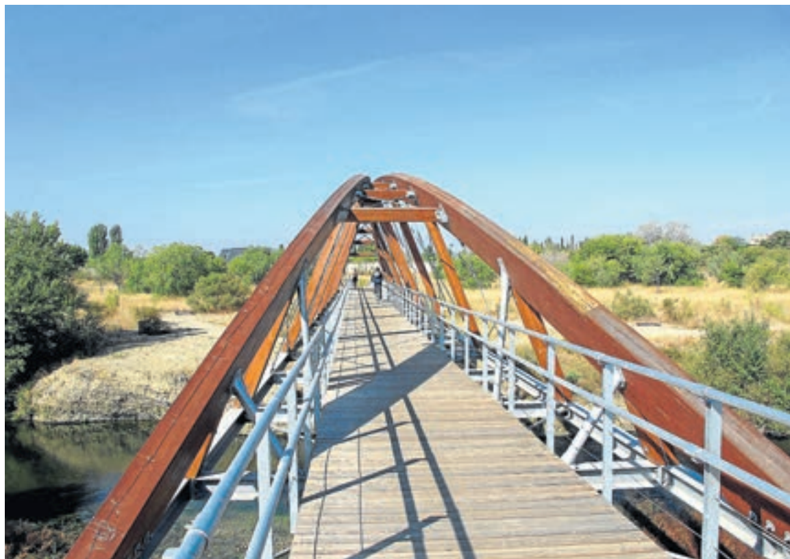
Pasarela en San Juan de Mozarrifar (tramo 3). FERNANDO LAMPRE
